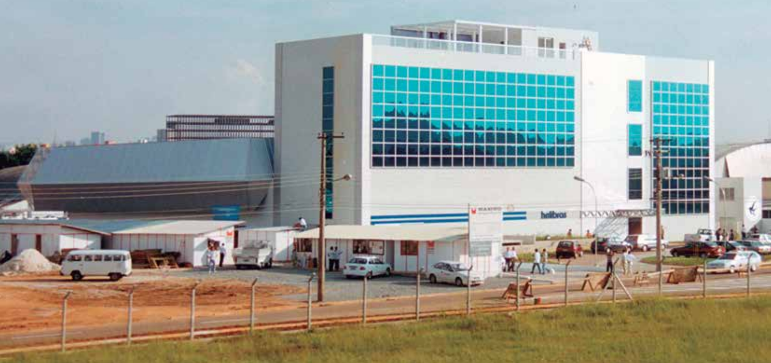
As instalações da Helibras no Campo de Marte, em São Paulo, foram inauguradas em 1998
